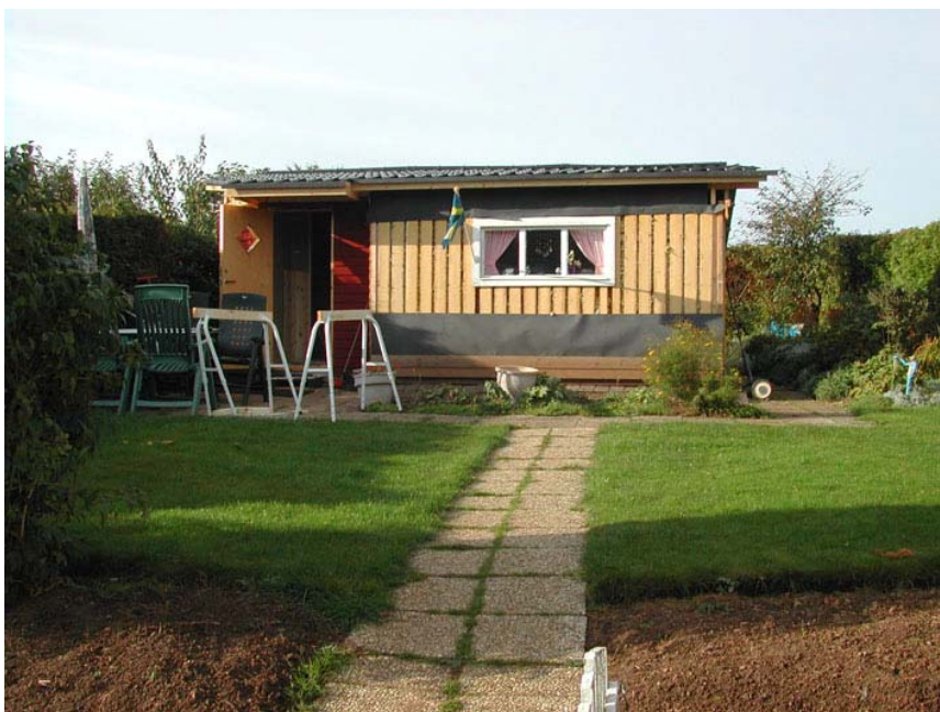
Tilläggsisolering av stuga pågår i koloniträdgård nummer 84.
