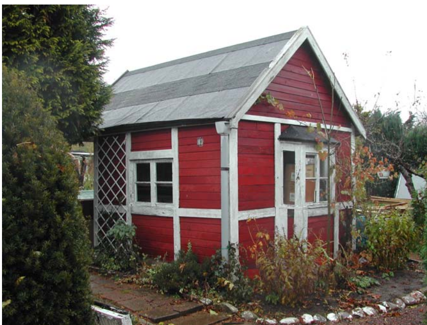
En rivningshotad stuga på tomt nummer103.
